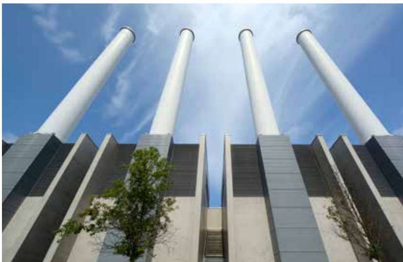
Kraft-Wärme-Kopplung-Zentrale neben der Coque
