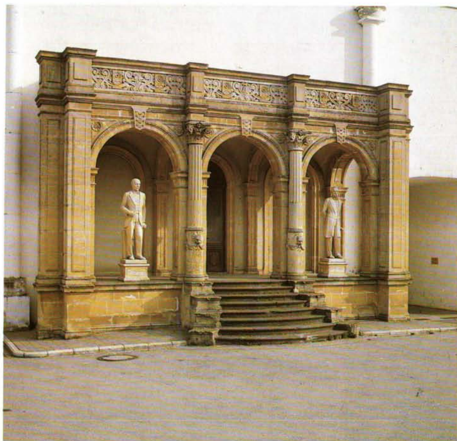
. . . und die Potemkinsche Fassade in der Bonneweger Rue de Neufchâteau.
