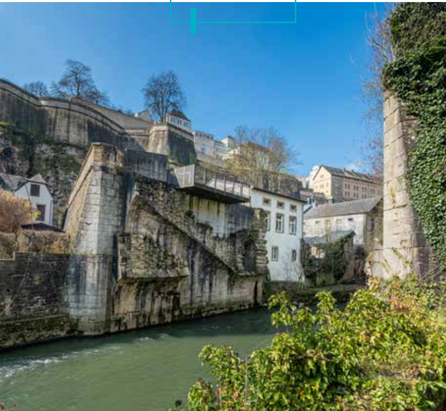
L'écluse du Grund.
