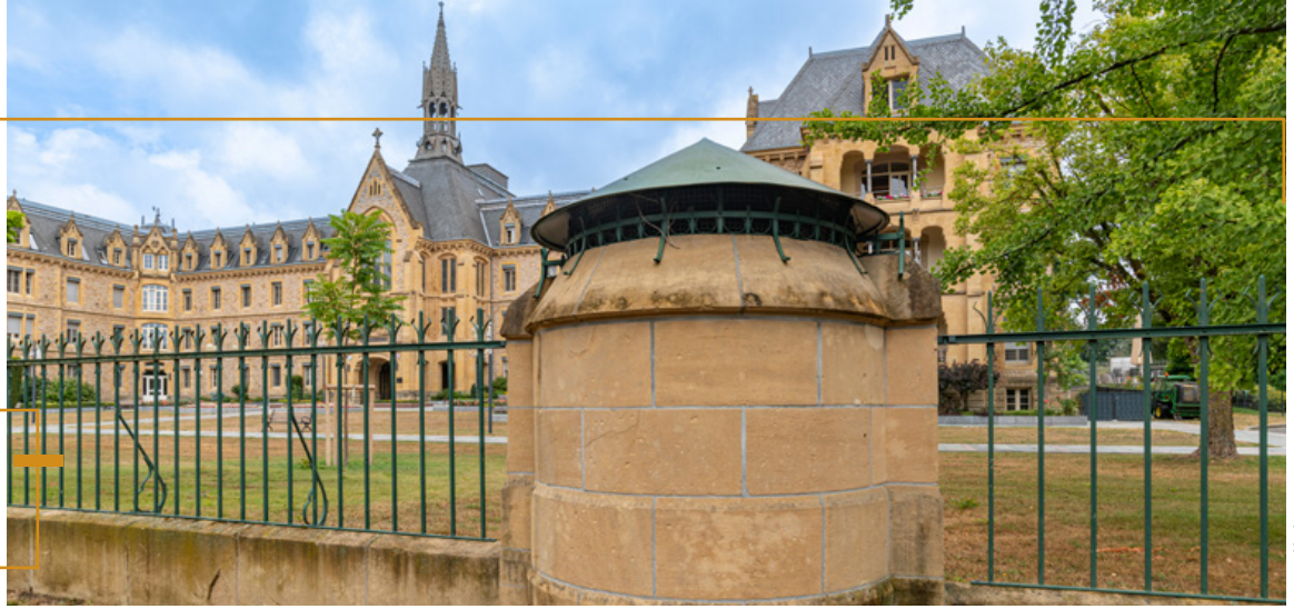
Fort Berlaumont: Entlüftungsschacht über dem Réduit.
