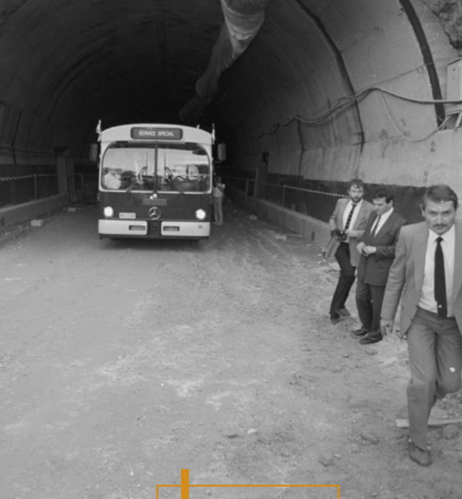
Premiers essais du passage des bus.
