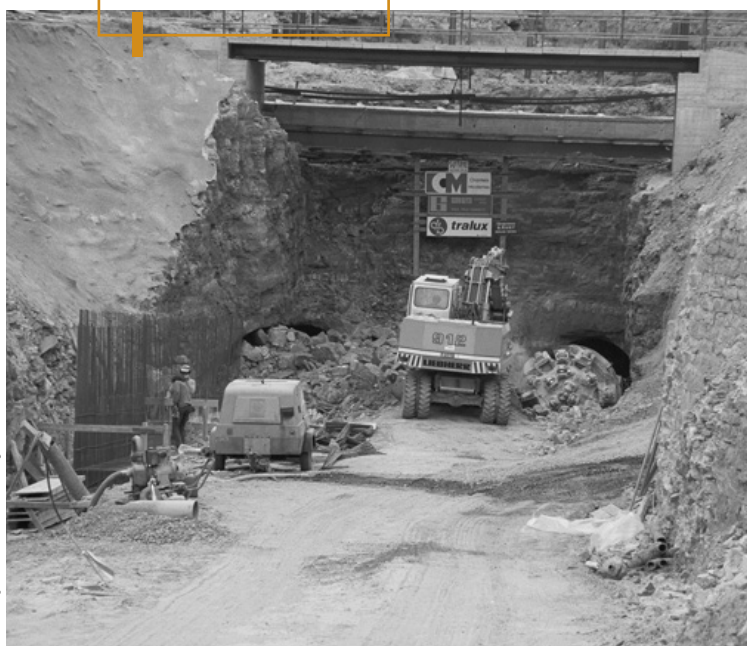
Les débuts du forage du tunnel au plateau du Saint-Esprit.
