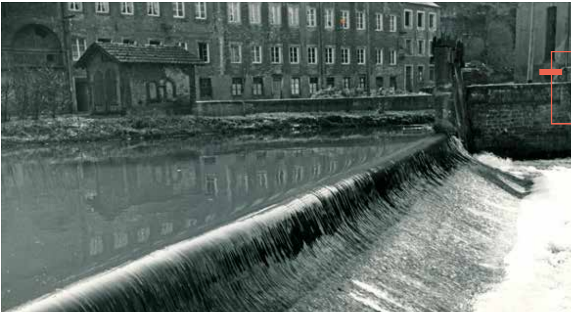
Das Wehr bei der Tuchfabrik Schleifmühle
