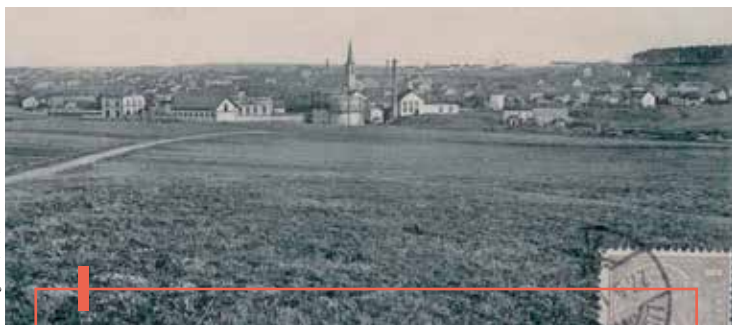
Postkarte mit Sicht vom Geesseknäppchen auf das Hollericher Gaswerk. Links davon das noch heute bestehende Schlachthausgebäude. (Mit freundlicher Genehmigung des Auktionshauses Kanerz Art)
