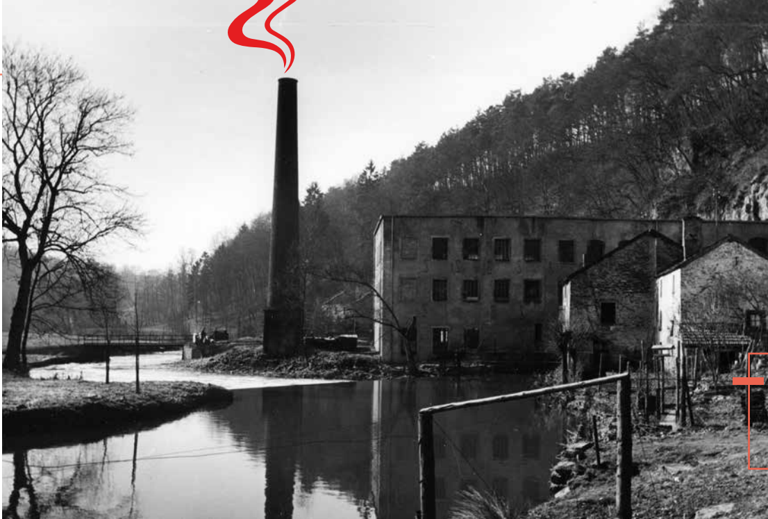
Spuren der Erinnerung: Schleifmühle mit Schornstein.
