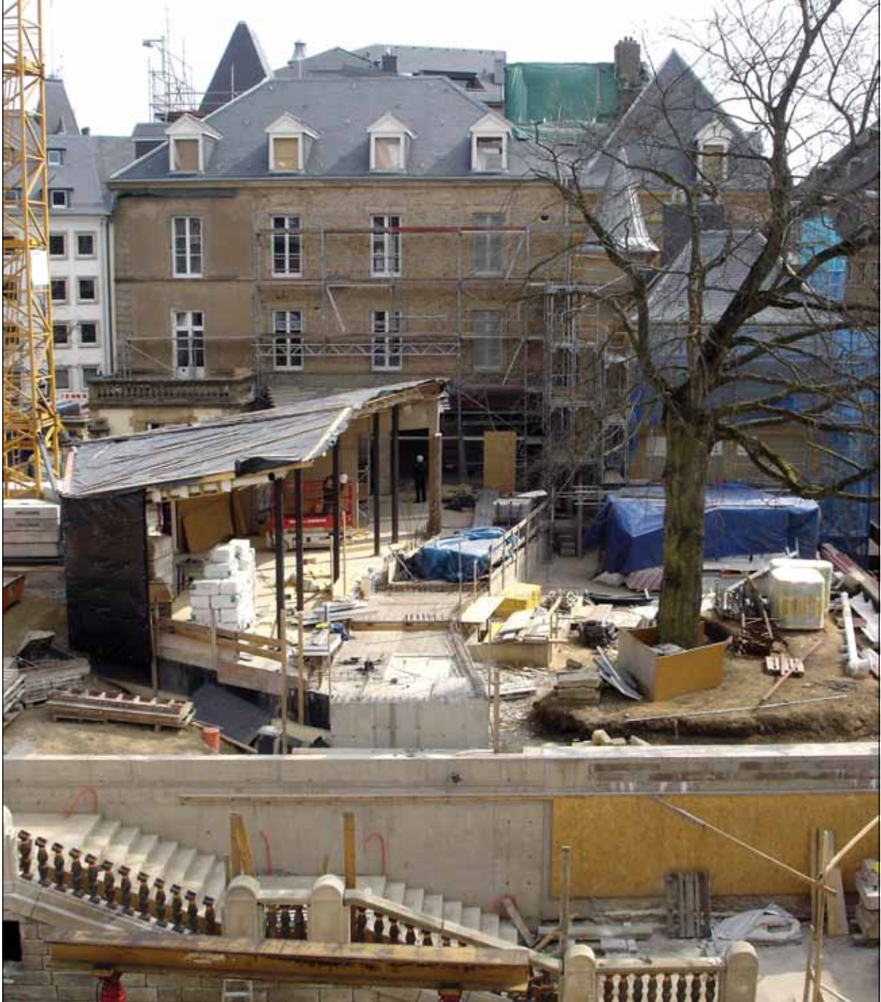
Die Baustelle des Centre Guillaume II
