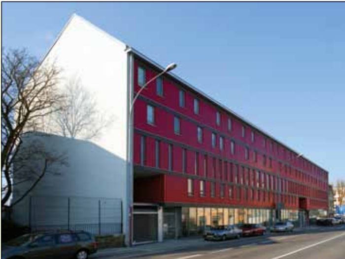
◀ Neubau des Fonds du Logement in der Hollericher Straße
