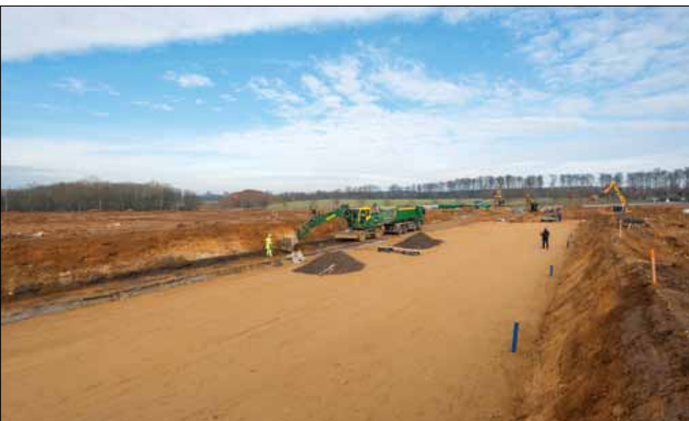
Blick auf die Baustelle: In unmittelbarer Nähe der LuxExpo entstehen 900 Wohnungen.
