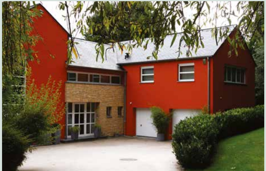
Bei diesem Neubau in einem Quellengebiet in Dommeldingen war es eine baubiologische Herausforderung, das Mauerwerk gegen aufsteigende Feuchtigkeit aus dem Erdreich zu schützen.
