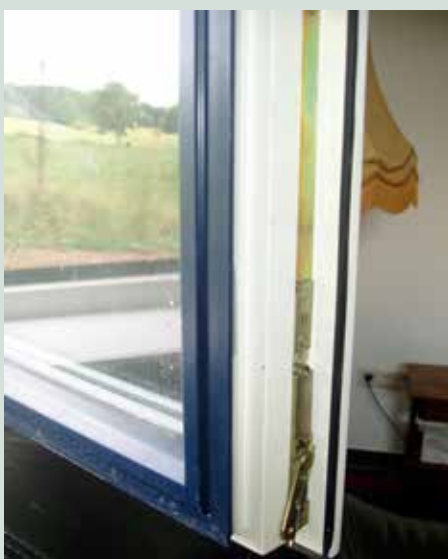
An diesem Fensterrahmen wurde an der Außenseite langlebiges, pflegeleichtes Aluminium benutzt, als Abschirmung gegen Mobilfunk, innen aber warmes, lebendiges Holz.
