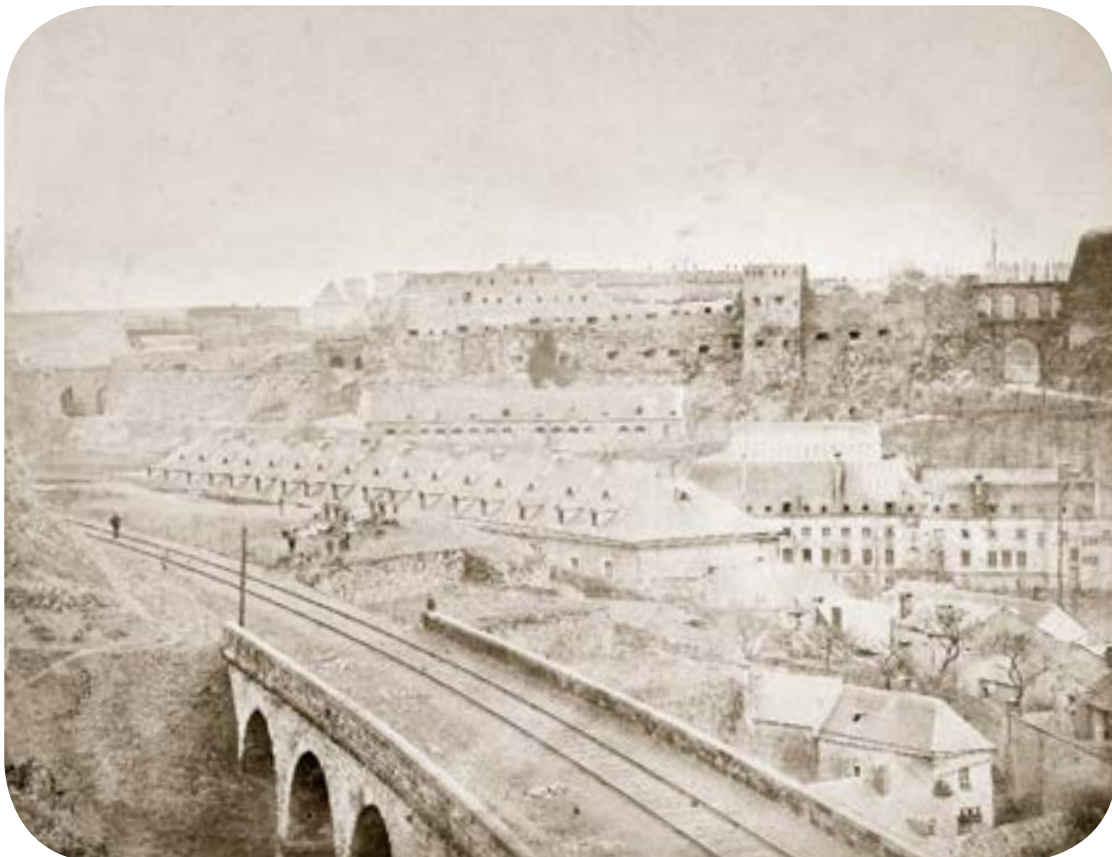
Abbruch der Bockbefestigung.
