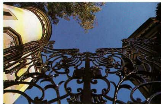
La grille rocaille en fer forgé, entre les tours d'entrée construites par Jean-François Boch.
