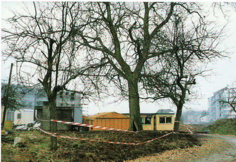
Fachgerecht gegen die Bauarbeiten geschützter Baum auf der Baustelle des „Konviktsgaard“.
