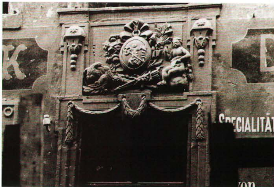
1904 Porte de l'ancienne maison Michaëlis (Marché-aux-Poissons, démolie vers 1903).
