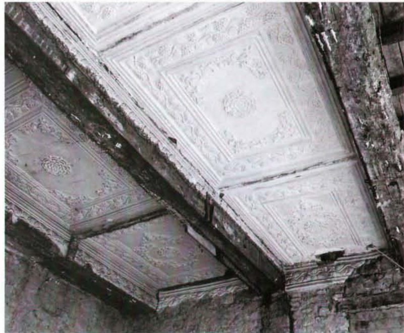
Stuckdecken aus dem 17. Jahrhundert wurden, wie hier, im 18. Jahrhundert von den Orvaler Mönchen ergänzt.
