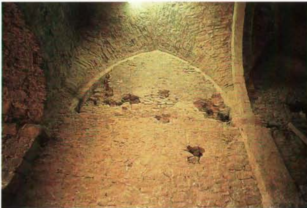
Die Kellergeschosse des Gebäudekomplexes reichen bis ins Mittelalter zurück.
