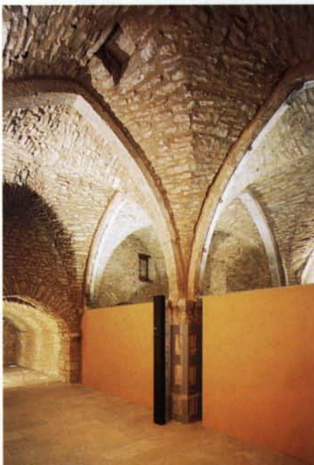
Kreuzgratgewölbter Keller (14./15. Jahrhundert)
