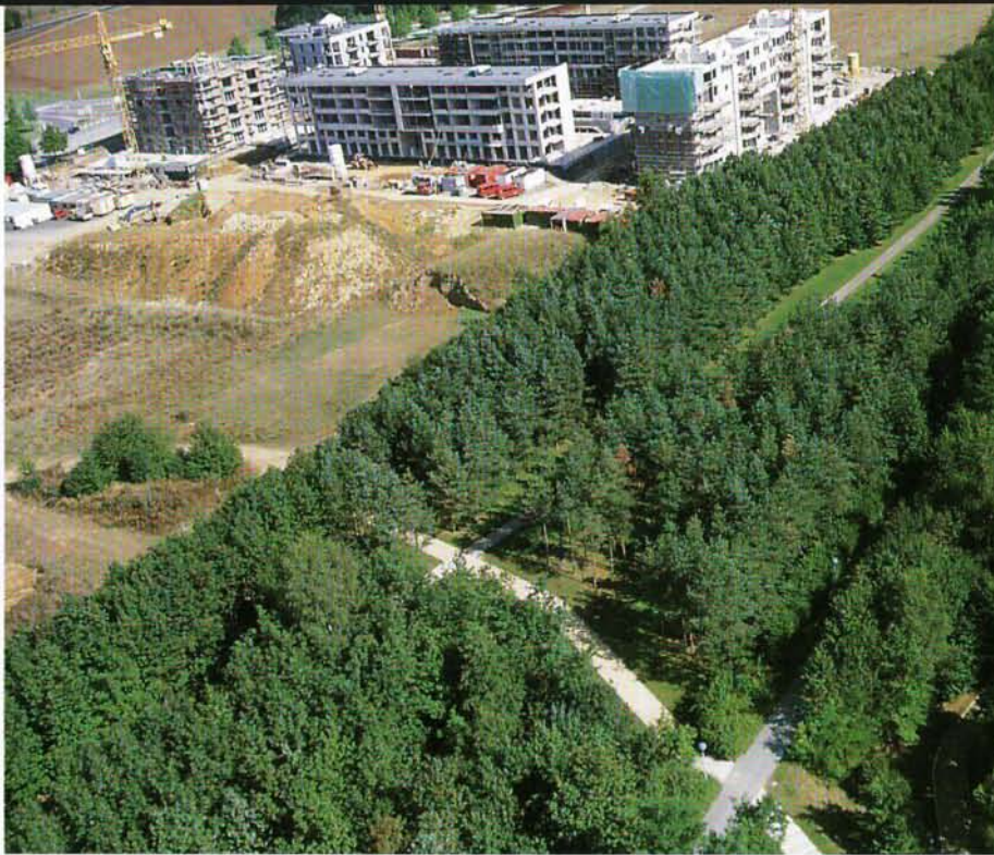
Das Neubaugebiet Avalon am Park Réimerwee
