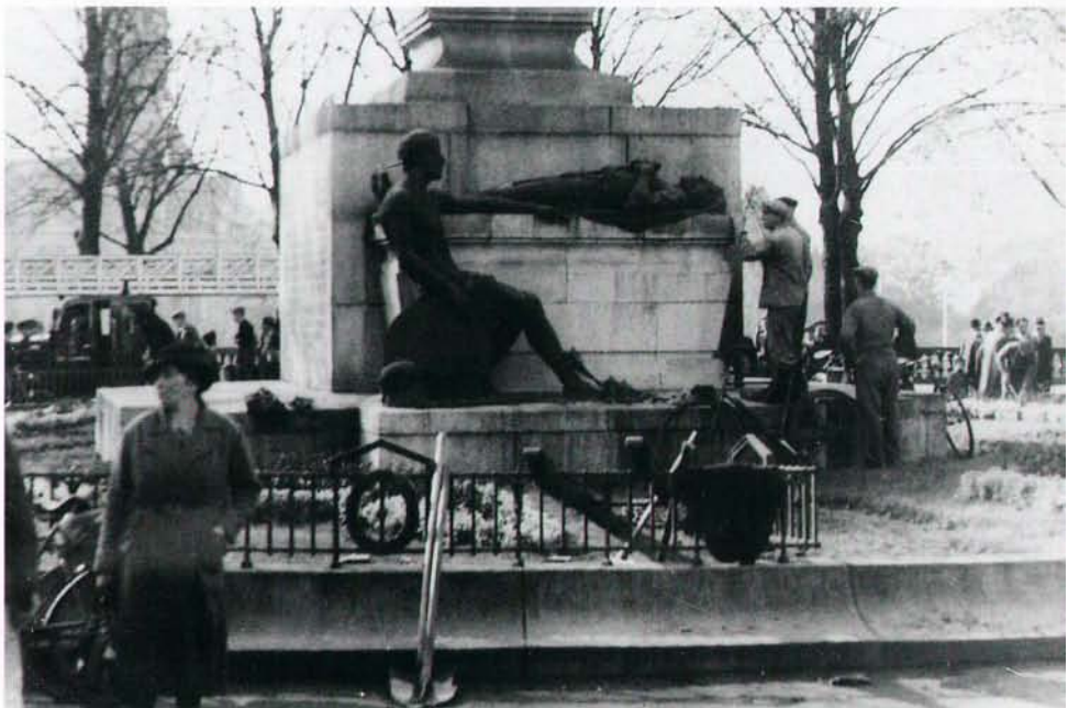
Der Beginn der Abrißarbeiten
