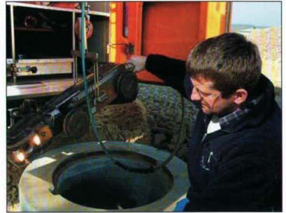
Kanalinspektion durch selbstfahrende Inspektionskamera: Einbringen des Kamerawagens in die Kanalisation
