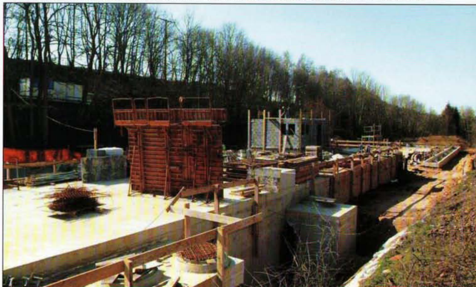
Bau von neuen Anlagen zur Regenwasserrückhaltung und Mischwasserbehandlung: Baustelle Val de Hamm
