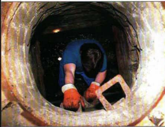
Begehbare Mischwasserkanalisation (Mühlenbachsammeler, Rue des Réservoirs), Bild Mitte
