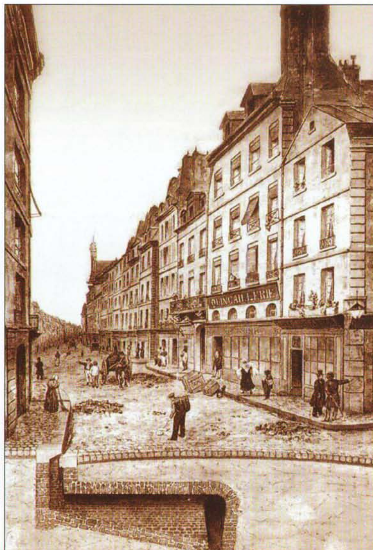
Paris: Reinigungsarbeiten in der Rue Saint Antoine mit Kanalanlage im Querschnitt (1830)
