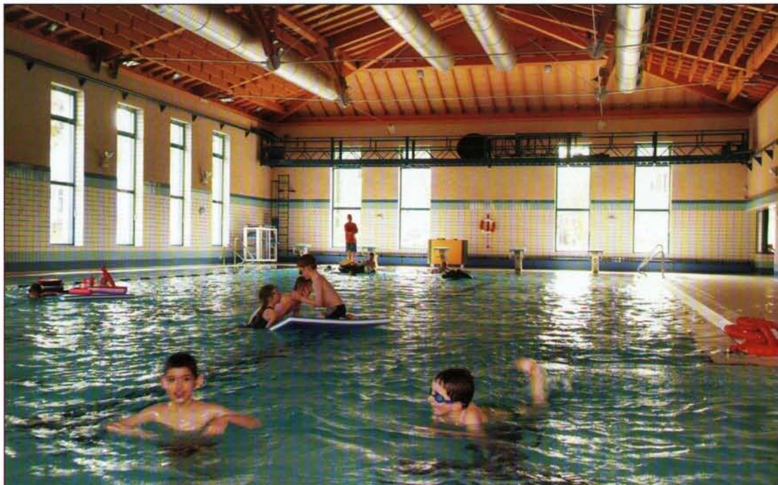
La nouvelle piscine de Limpertsberg, équipée de panneaux solaires thermiques
