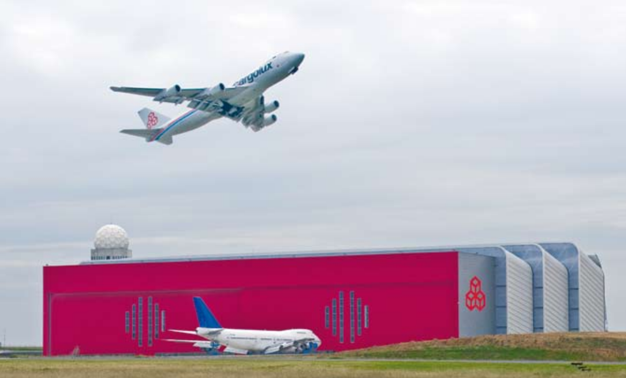
Die neue Cargolux-Wartungshalle: ein Koloss aus Stahl und Aluminium
