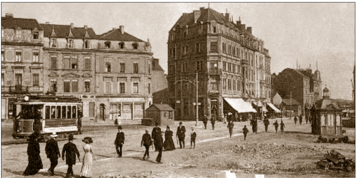
Abb. 3: Das Oktroibüro (rechts) am Pariser Platz (1910). Ein fast identischer Pavillon steht heute beim Spielplatz im unteren Stadtpark.
