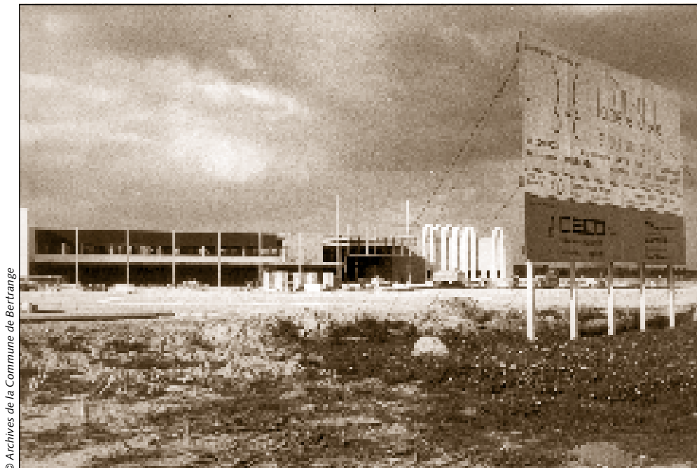
La «Belle Étoile» en construction (1974) et en chantier renouvelé (2012)
